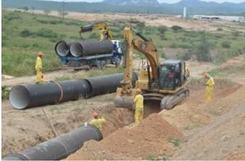
**Os sistemas de tubulações de ferro fundido dúctil** da Saint-Gobain Canalização são utilizados nos grandes projetos de fornecimento de água do Nordeste (especialmente em Agreste e Pajeú). Essas obras de várias centenas de quilômetros fornecerão acesso à água para milhões de habitantes da região.
